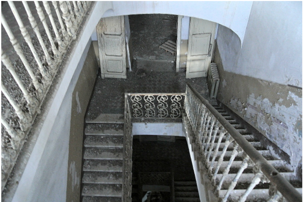
Scalinate interne albergo stazione
