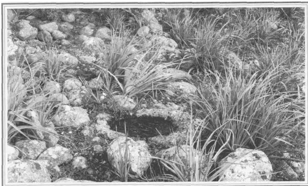
Serra Linta. Tracce di paramenti murari.
